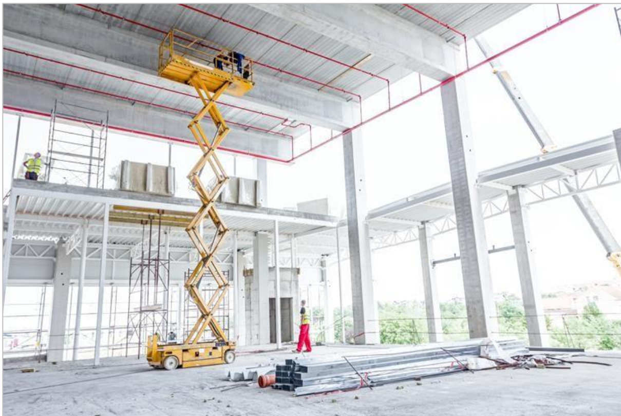
Podnośnik nożycowy używany do budowy
